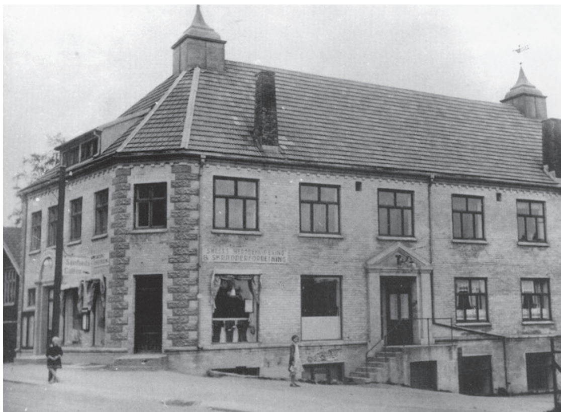
Arbeidersamfundet var Mysens forsamlingssal, festsal og kinolokale fra det ble bygd i 1922 til Festiviteten stod ferdig i 1958. Første etasje inneholdt også forretningslokale, og her holdt dessuten Samfundskaféen til (opp trappen). I kjeller-etasje var det vaktmesterleilighet og en mindre sal. Tekst og bilde lånt fra Hans Wålers Mysen-leksikon,
