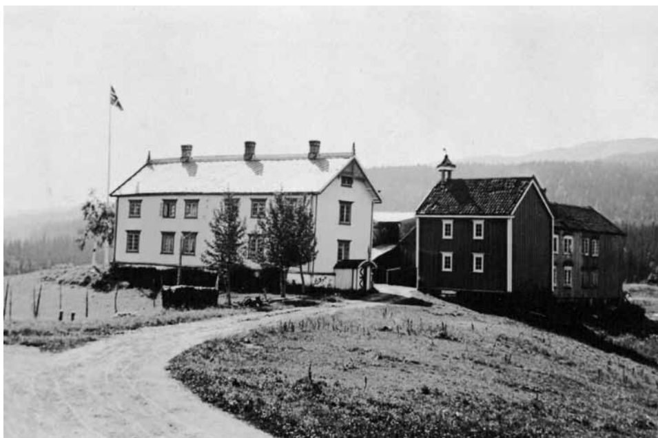
Forseth øvre, gnr. 38, bnr. 2. Foto tatt før 1940. Våningshus fra ca. 1770, restaurert ca. 1920. Driftsbygning fra 1890.
