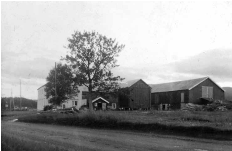
Osen nedre, gnr. 5, bnr. 1. Foto fra ca. 1960. Hovedbygning fra 1835, fjøs fra 1928.
