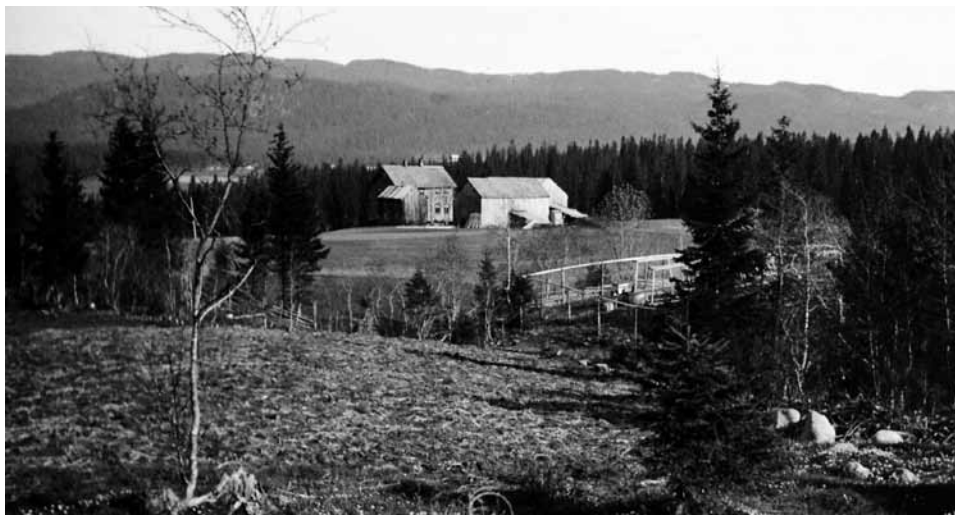
Svån gnr. 2, bnr. 3. Foto fra ca. 1945/46. Hovedhus og låve fra 1914, fjøs og stall fra 1891. Gammelstua til v. mye eldre. Husa ble revet i 2003.
