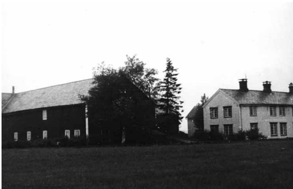
Storugla øvre, gnr. 9, bnr. 1. Foto fra 1953. Våningshuset fra 1850, uthus fra 1909 - 13.
