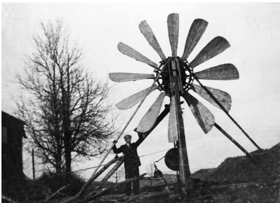
Vindmølle på Nordset vestre, bygd av John Østhus og Leif Aspli (på bildet) i 1930-åra. Mølla drev dreiebenk og kappsag. John Østhus bygde en større vindmølle i 1918. Den blåste ned i 1921. Foto fra ca. 1935.
