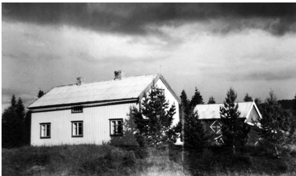
Nesheim, gnr. 30, bnr. 4. Foto ca. 1955. Hovedbygning fra 1870. Stall fra 1910.
