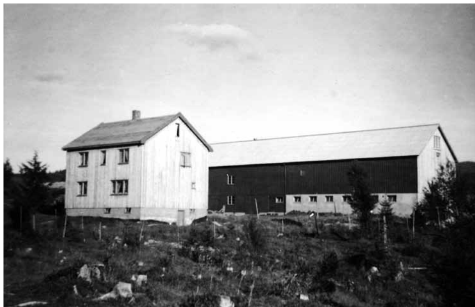
Rønningen nordre, gnr. 6, bnr. 3. Foto fra ca. 1960. Tunet bygd opp i 1958-59.
