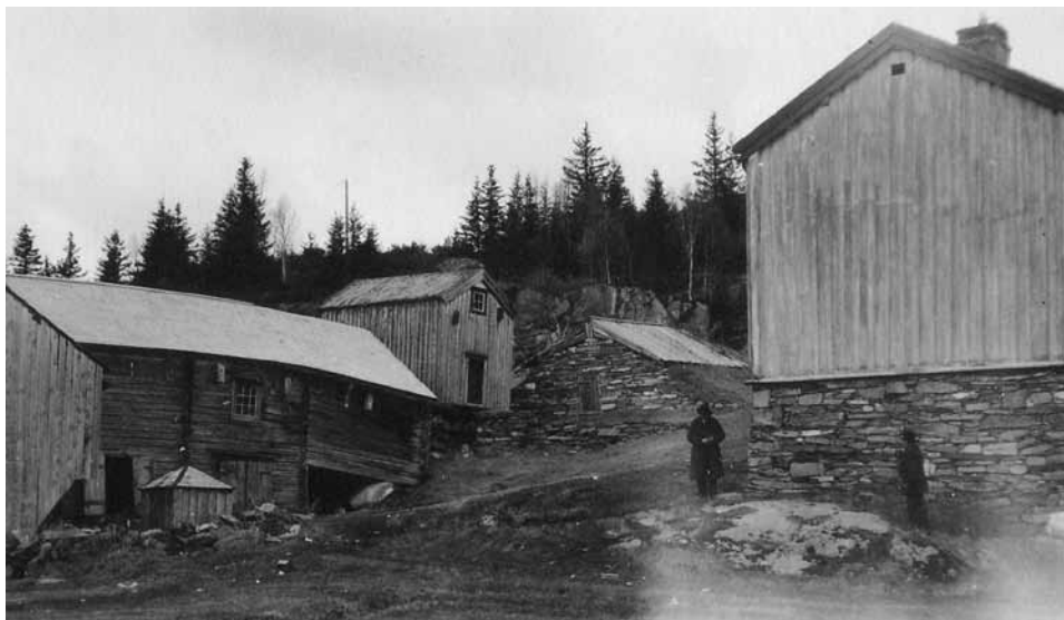
Teigen, gnr. 28, bnr. 3. Foto fra 1917. Hovedbygning, jordkjeller og bur oppført ca. 1860. Teigen er idag Klæbu Bygdemuseum. Foto: T.E.V.
