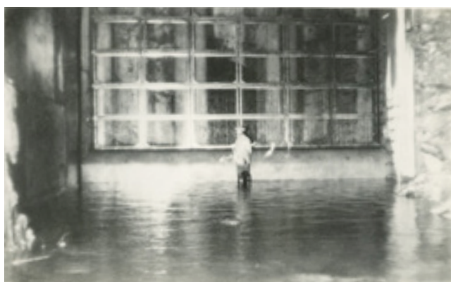
Det var dimensjoner over installasjonene i tunnelen. Øverst: 100 tonns luke. Nederst: grovrist Foto: Historielagets fotosamling, Jacob Salbergs album.
