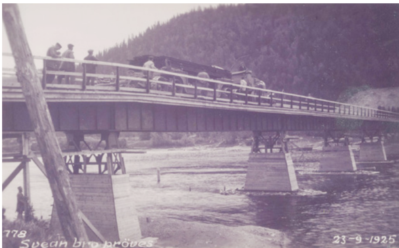
Brufundamentene under Svean bru er tømmerkasser fylt med stein, og pillarene ble satt opp på disse. Foto: Historielagets fotosamling, Ole Svaans album.
