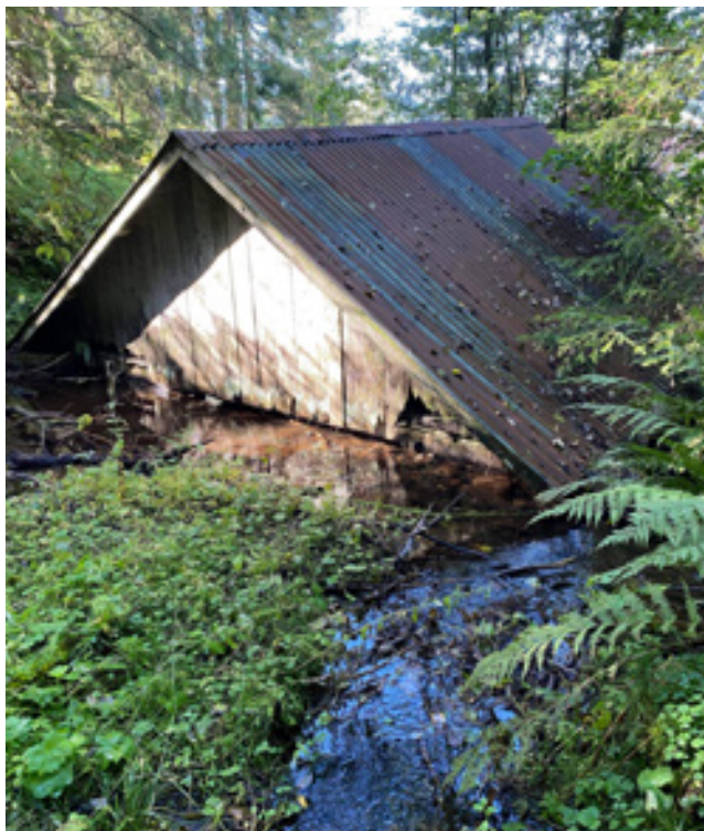
Vasshusets bakside: grunnflate 4 x 5 m, dybde ca 1,5 m. Kaldveller på begge sider av bekken gjør dette til en meget våt plass.
