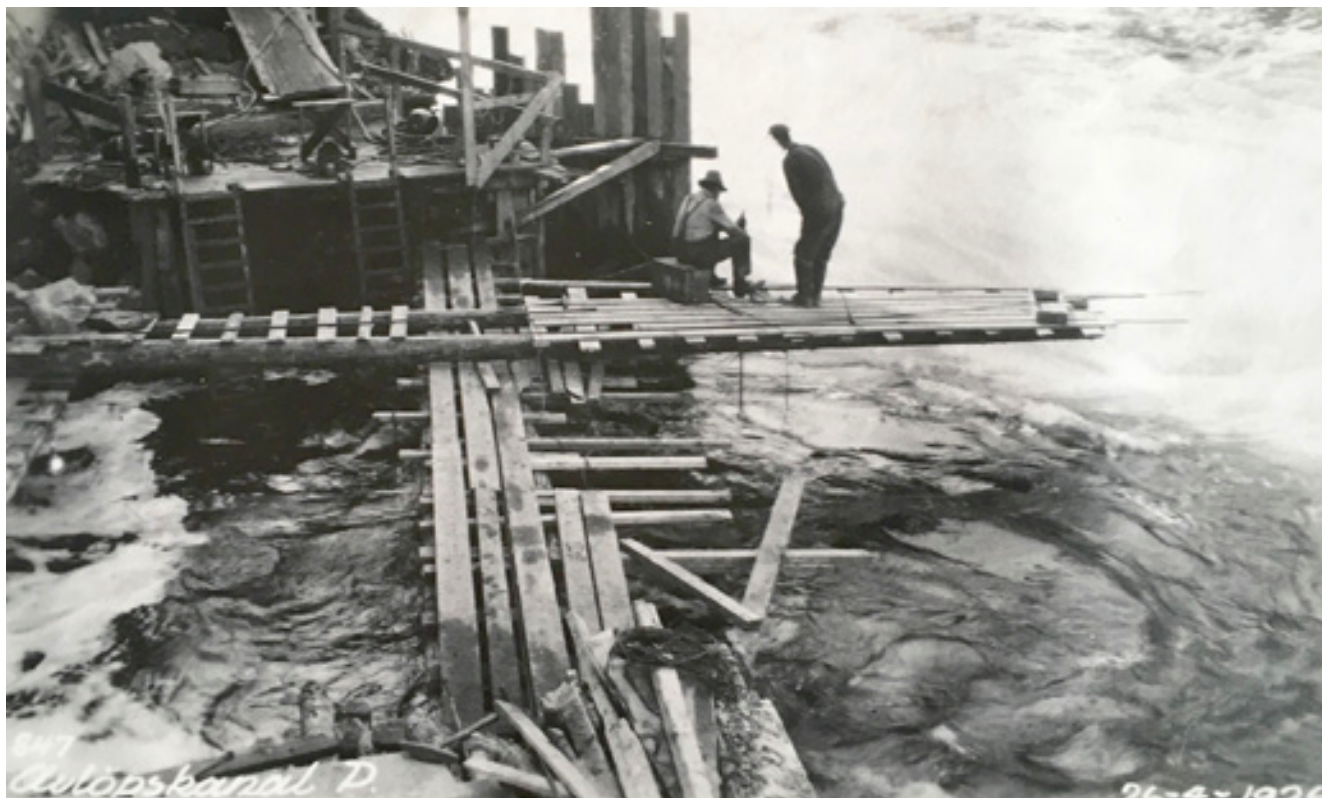
Fra bygging av kraftstasjonen i Løkaunet 1926. Foto: Historielagets fotosamling, Jacob Salbergs album.
