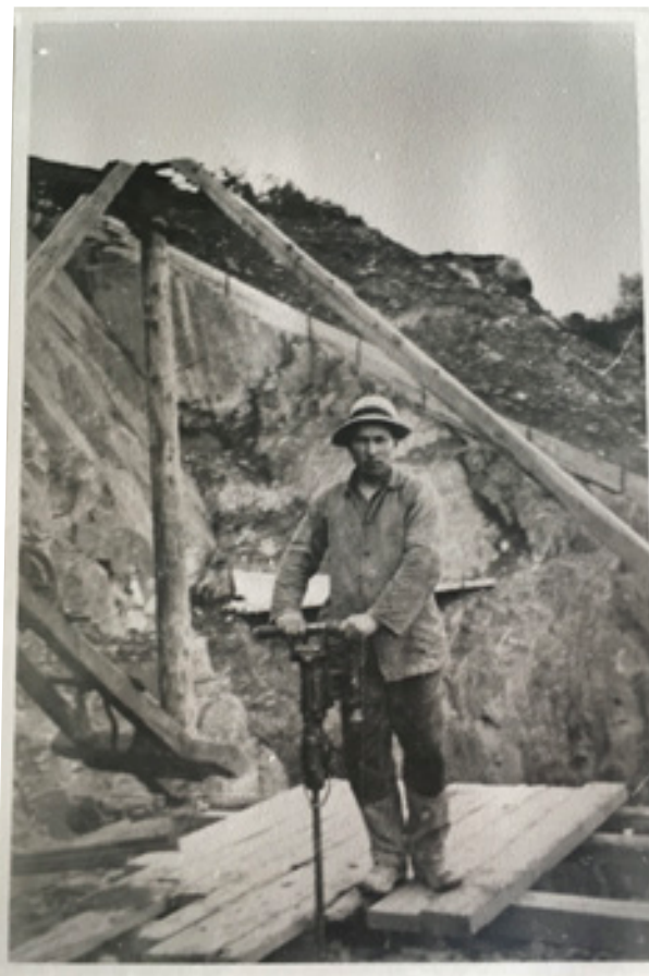
En av de første slagboremaskinene som ble tatt i bruk ved kraftverksutbyggingen.
