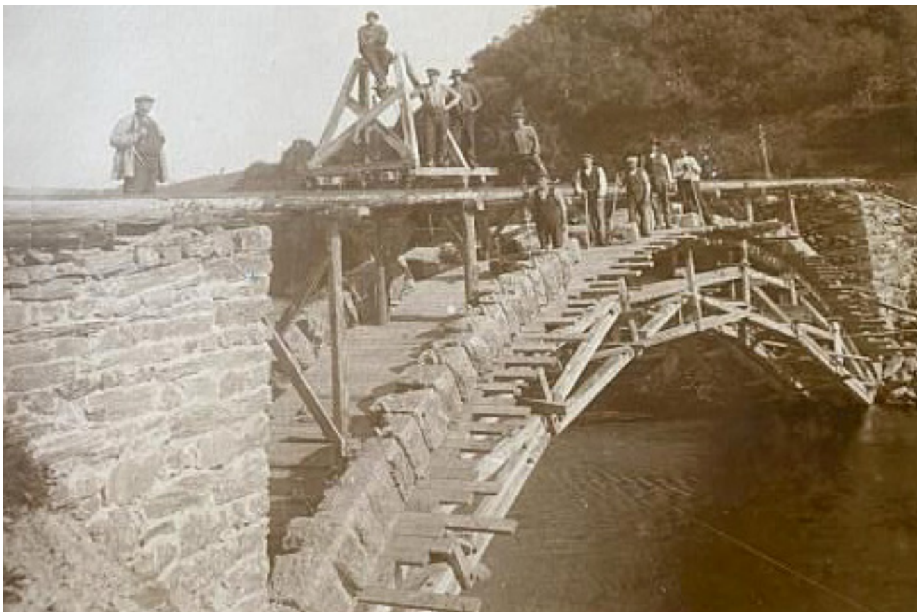
Bygging av Tiller bru i 1911. Fra v.: Arbeidsformann Bjørnås, Martin Skjetneli (sittende), ukjent, Bernt Skjetneli, Petter Broli, ukjent, Halvor Fosseide (hvite skjorteermer), Graus Røv fra Sunndal, ukjent, Andreas Nordseth (bakerst). Foto: Lars Nordtiller. Kilde: Tiller: bygd og by av Henry K. Jensås 1980. Foto utlånt av Halvor Fosseide d.y.
