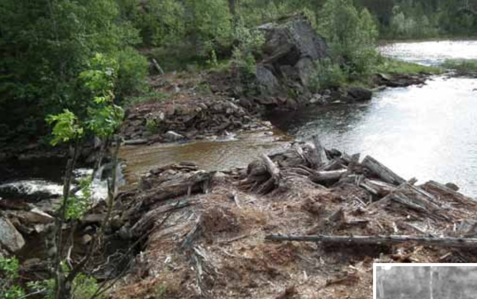
Damanlegget i Donnøyvatnet slik det framstår i dag. En kan tydelig se hvordan anlegget var bygd.
