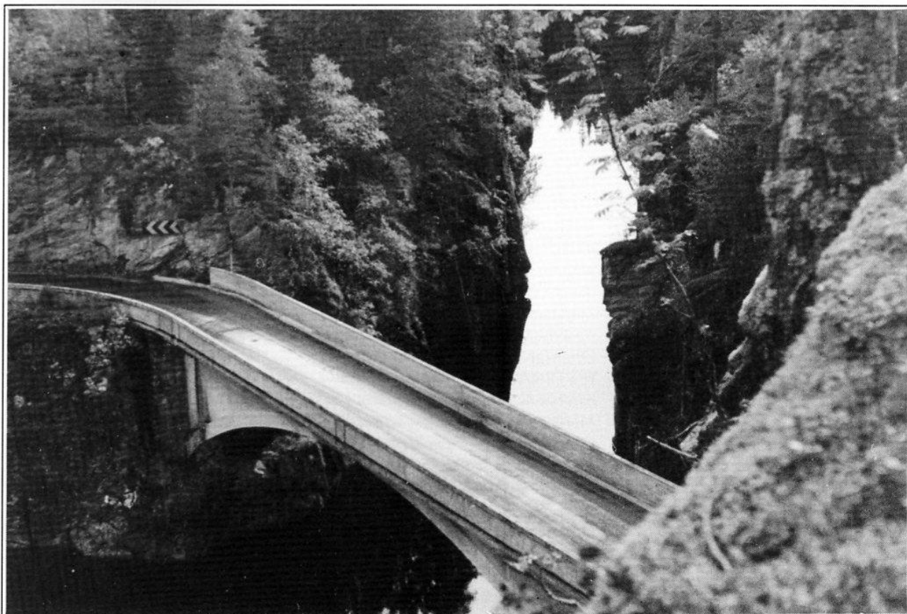
Trangfossbrua med bergkløften ovenfor.
