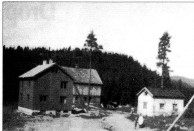
Bureisingsbruket «Bjørnstad». I den lille stua til høyre på bildet bodde John sammen med sine foreldre i flere år mens våningshus og driftsbygning ble reist.
