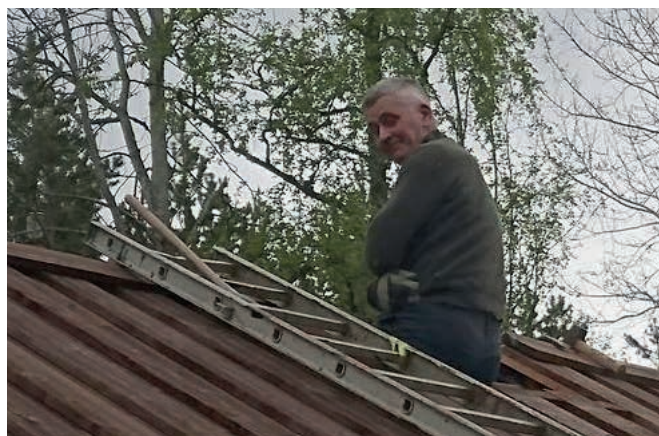
Kåre Haugen på taket på mastua på Teigen, i ferd med å rive murpipa. Fotograf: Ronny Wigdahl
