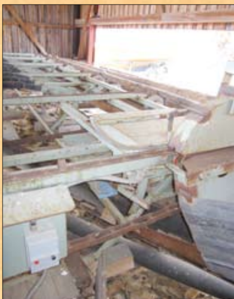
Rester av teknisk utrustning.
