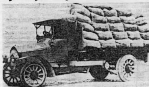
Den første MAN-Saurer-lastebil fra 1915 hadde en totalvekt på fem tonn. En firesylindret motor på 37 hk, og overføringen til bakhjulene skjedde med kjededrift.
