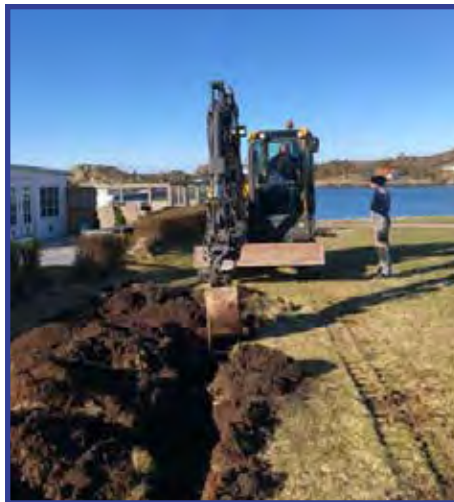
Formann kjører gravemaskinen.
