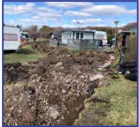
Åpning av vann og strøm 26. mars.
