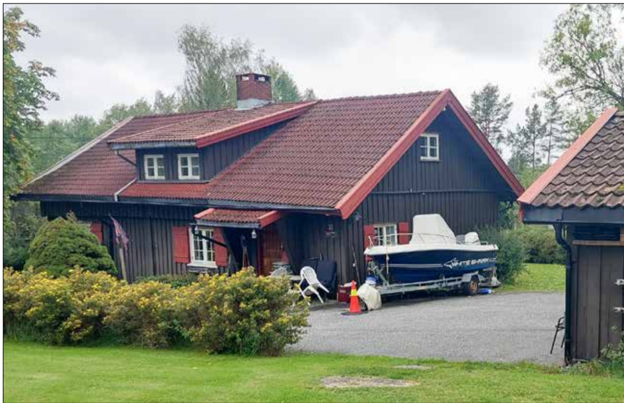
Våningshuset på Li gård anno 2023. Foto: Ole K. Endresen
