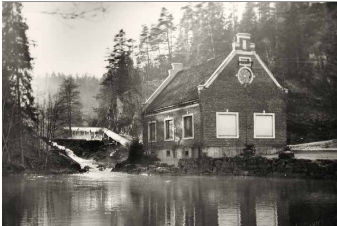
E-verksbygningen, senere bilverksted. Elva var demmet opp ved Kruttmølleplass. Foto: DM
