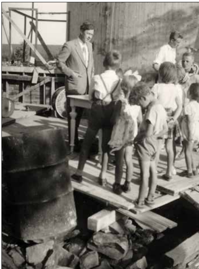
Spente barn følger bygging av vanntårnet. 1956
