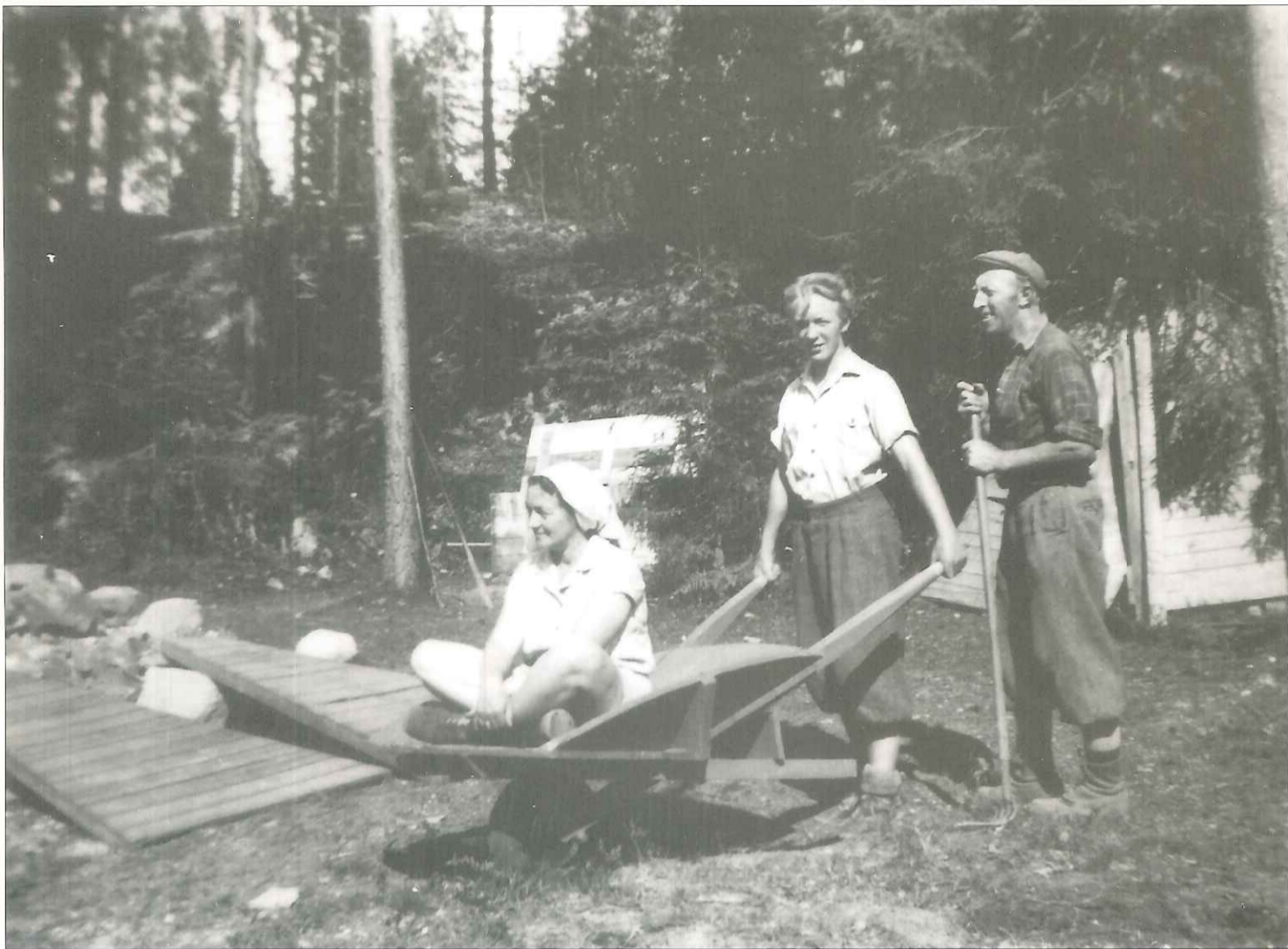
Familien Arnesen fra byggingen av "Arneli". (Foto utlånt fra historisk bildearkiv Oppegård bibliotek).
