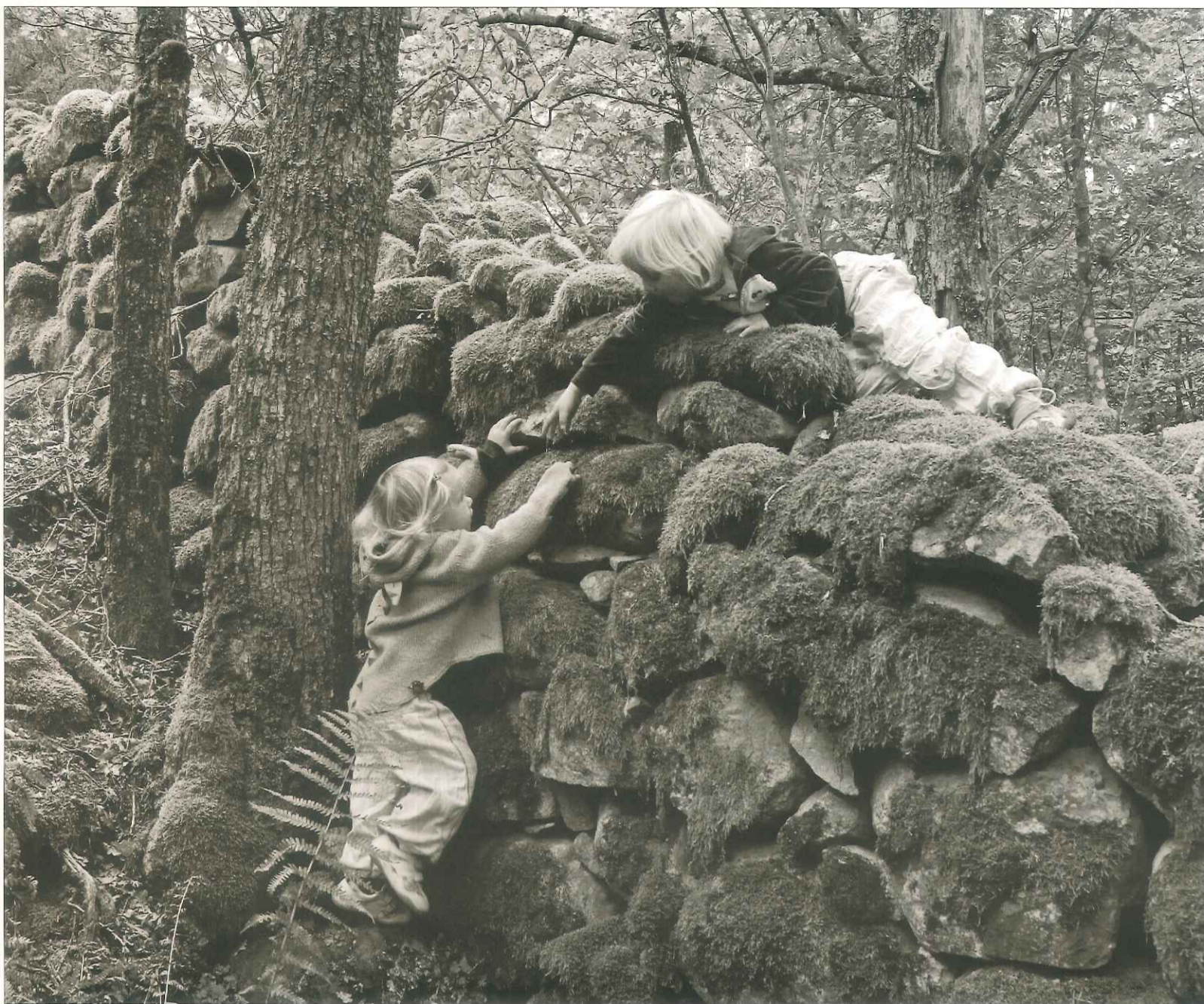
Kistemur med to likeverdige murvanger med fyllmasse mellom vangene er den vanligste type steingjerde på Svartskog. Dette steingjerdet ligger ved Solheim. (Foto Torbjørn Martinsen, illustrasjoner Nina Marika Kraft).
