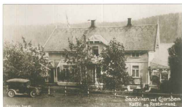
Skysstasjonen Sandviken Kaffé og Restaurant, i dag bedre kjent som Villa Sandvigen, betjente trafikken langs Gamle Mossevei. (Foto utlånt fra Villa Sandvigen).
