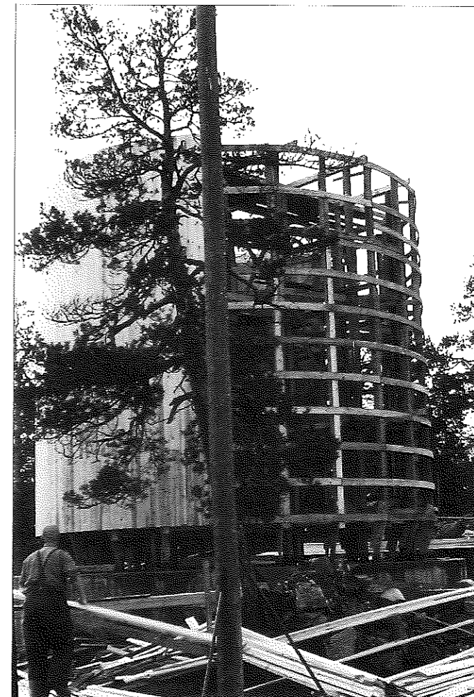
Støpingen av selve vanntårnet ble utført uten avbrytelse og var ferdig etter 26 timers kontinuerlig arbeid. 60 mann var med på den delen av dugnaden, og arbeidet ble utført på skift à 8 timer. (Foto: Knut Thorsteinsen).
