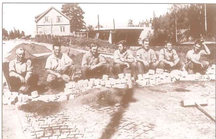
Da den nye Skiveien kom i 1936 ble eiendommen delt i to og butikken måtte bygges om.
