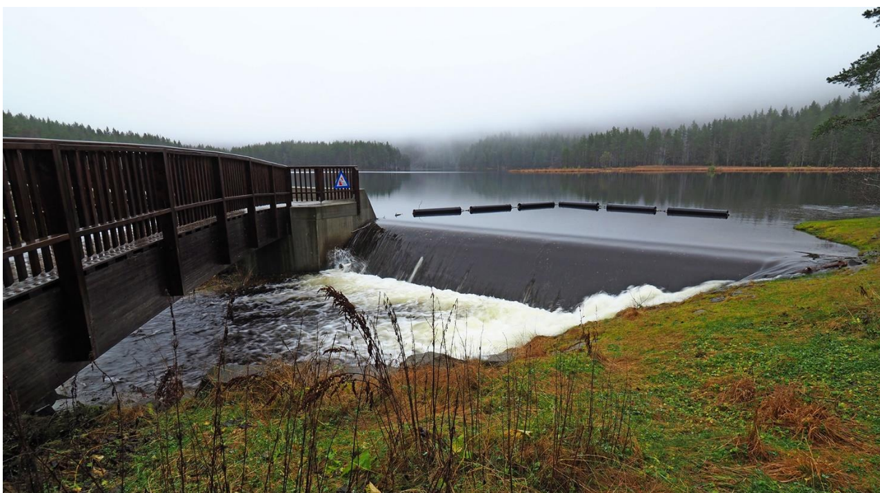
Den nye demningen Burudvann i liten flom med «fontene» rundt rørstussen. (Foto: OTS 2022.11)
