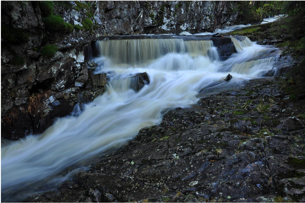
A51_B3340,05_A10_DSC_9141L1600 – Fangdemningen til vannverket i flom
