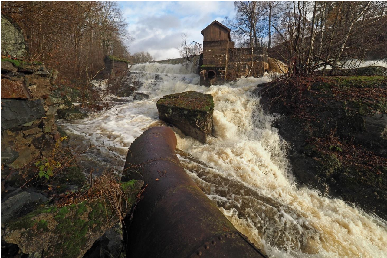
Vøyenfallet i middels høstflom kverna (fjernet), damhuset og røret til kraftverket. (Foto: OTS 2018.11)
