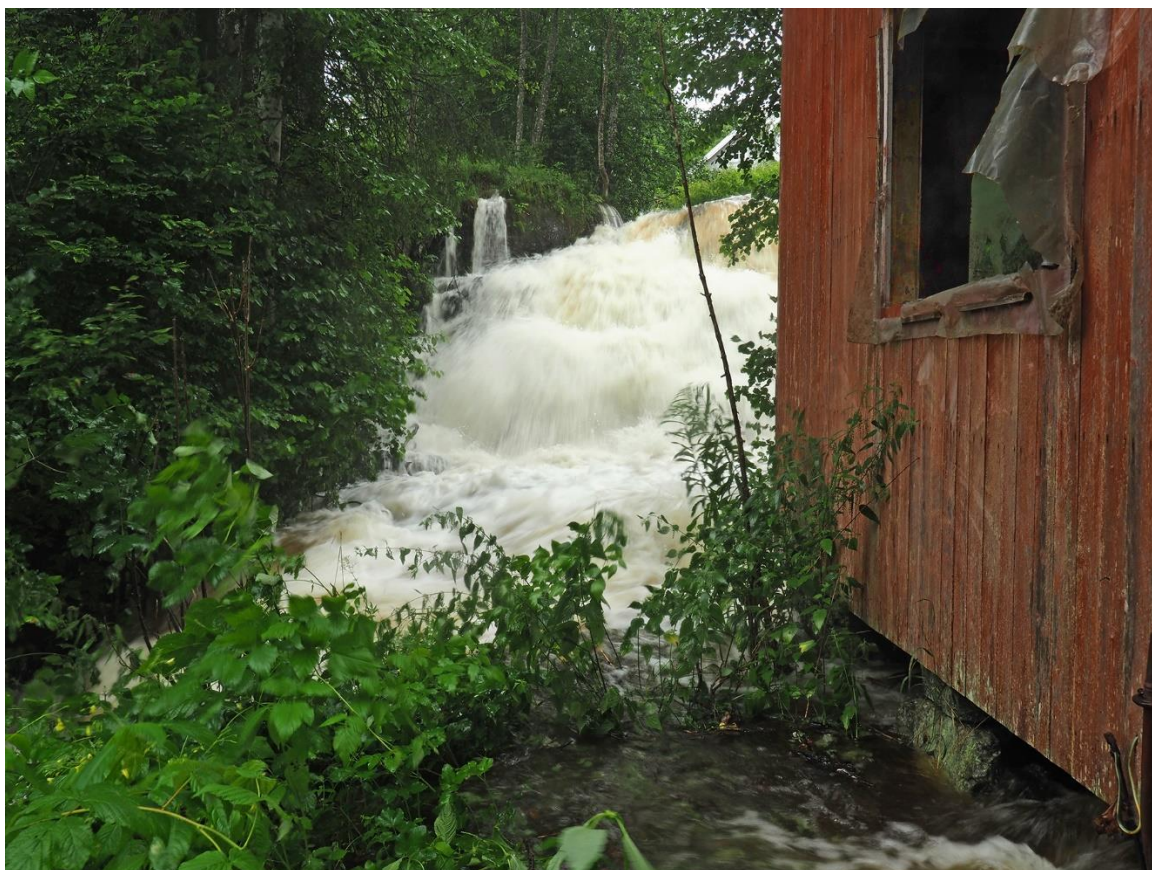
Kneikfossen i økende flom etter ekstremværet «Hans», med elv under bygningen. (Foto: OTS 2023.08)
