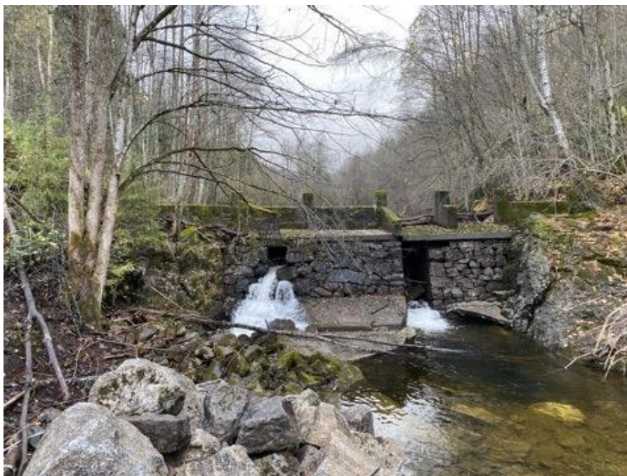
Bjørumdemningen i Isielva. Dette er en av de meget få gjenværende av de eldre demningene i Bærum. Den ble først anlagt i 17xx, og rehabilitert i 1853. Men snart blir den revet. Bærum kommune ønsker oppgang av laks og sjørret helt opp til Kneikafoss i Aurevannsbekken.
