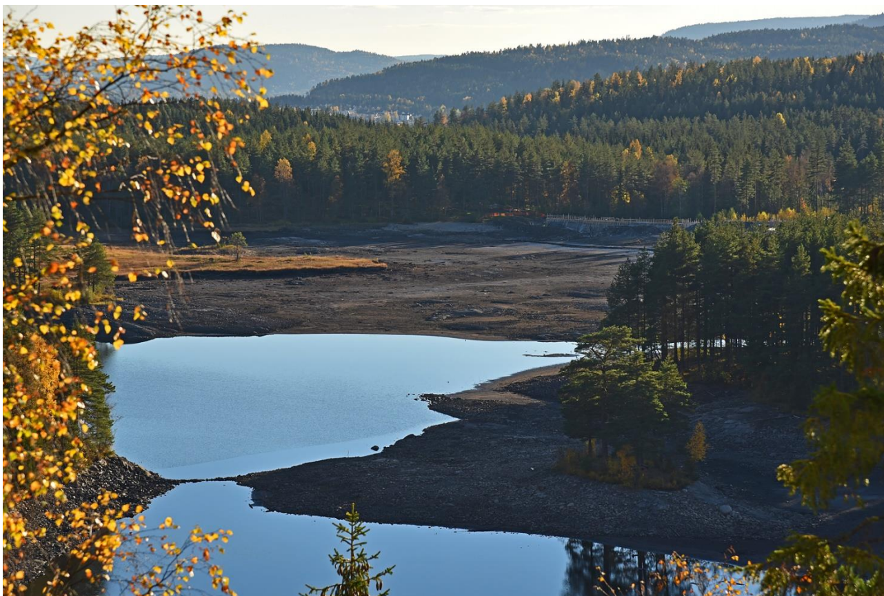
Burudelvas start: Burudvann, her nedtappet til to vann, omtrent som det var før det ble oppdemt. Utløpet og nåværende demning, som her er under rehabilitering, i bakkant. (Foto: OTS 2016.10)
