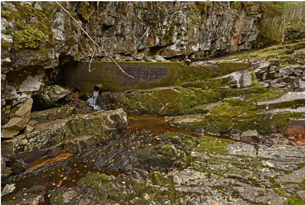
A52_B3340,05_A54_D75_2856L – Fangdemningen med rørstusser for vannledningen
