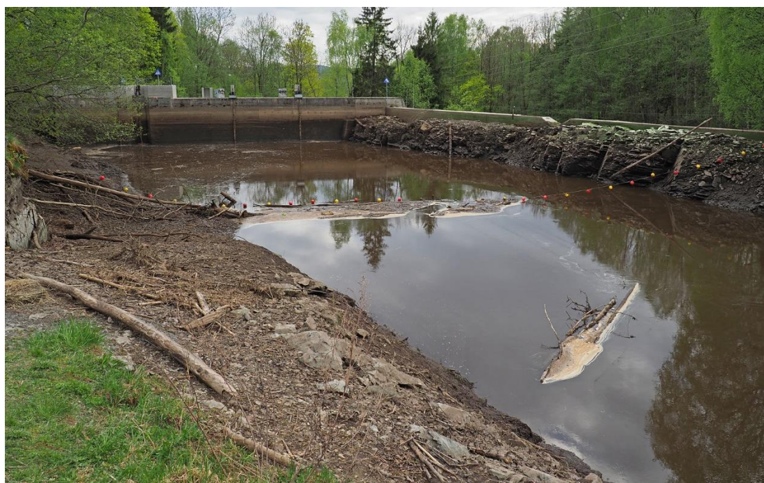
Vannsiden av demningen i Glitredammen delvis nedtappet i 2018. (Foto: OTS 2018.05)
