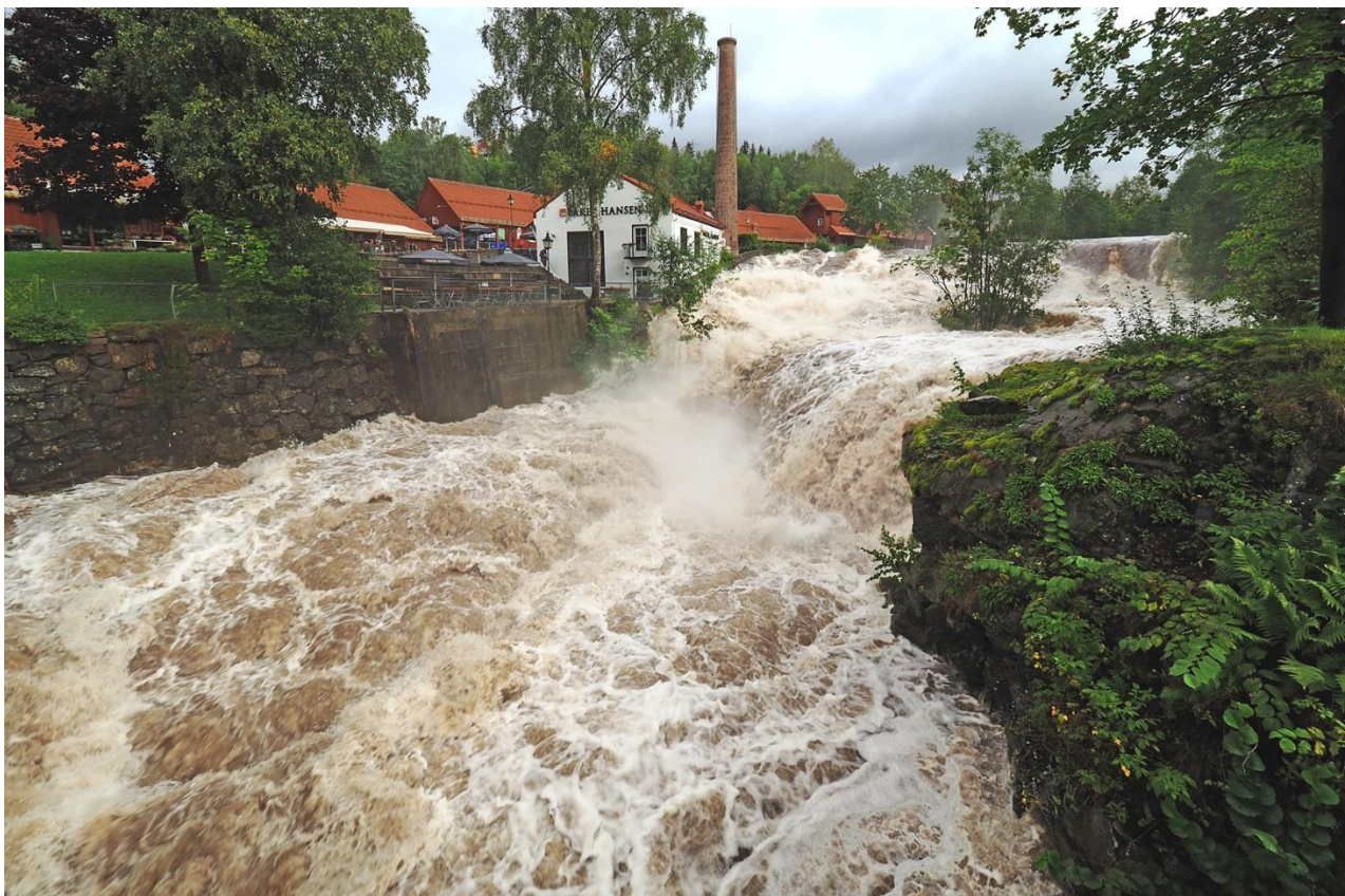
Verksfossen i storflom etter ekstremværet «Hans» sin etterfølger. (Foto: OTS 2023.08)
