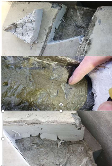
Bildene viser manglende heft til underlaget, hulrom og kanaler mellom fuge og betong, fuktig våt betong under fuge.
