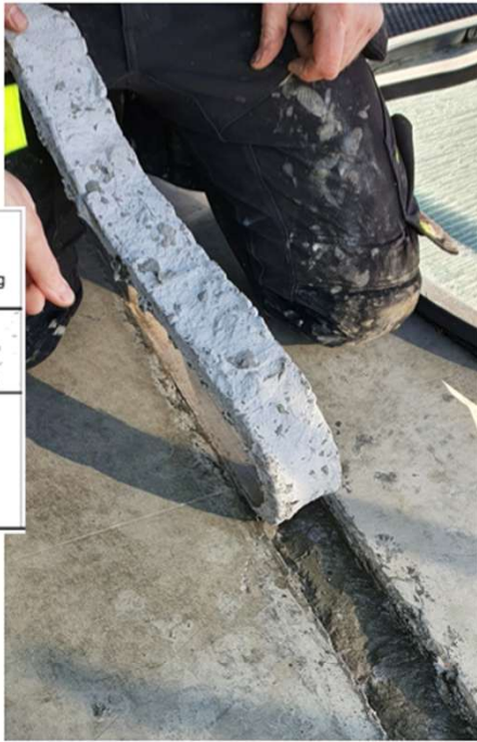
Bildene viser manglende heft til underlaget, hulrom og kanaler mellom fuge og betong, fuktig våt betong under fuge.
