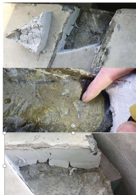
Bildene viser manglende heft til underlaget, hulrom og kanaler mellom fuge og betong, fuktig våt betong under fuge.
