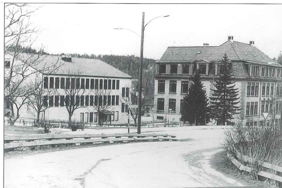
Greverud skole fotografert i 1982 - til høyre «gamleskolen» fra 1921 og til venstre den nye skolefløyen som var ferdig i 1973. For omtrent 10 år siden ble de to bygningene forbundet med et mellombygg.
