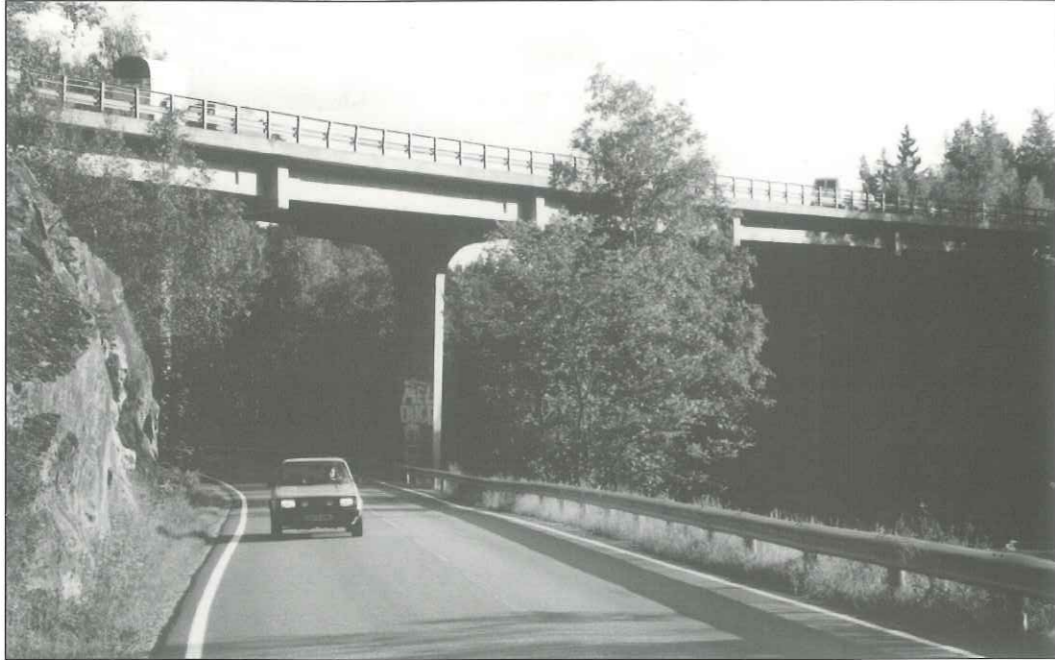
4. Den nye Mosseveien i bro over den gamle – Gjersjøelva skimtes såvidt til høyre. Noen hundre meter lenger sør krysser Gamle Mossevei over elva på Gjersjø bro, den siste fra 1931.
