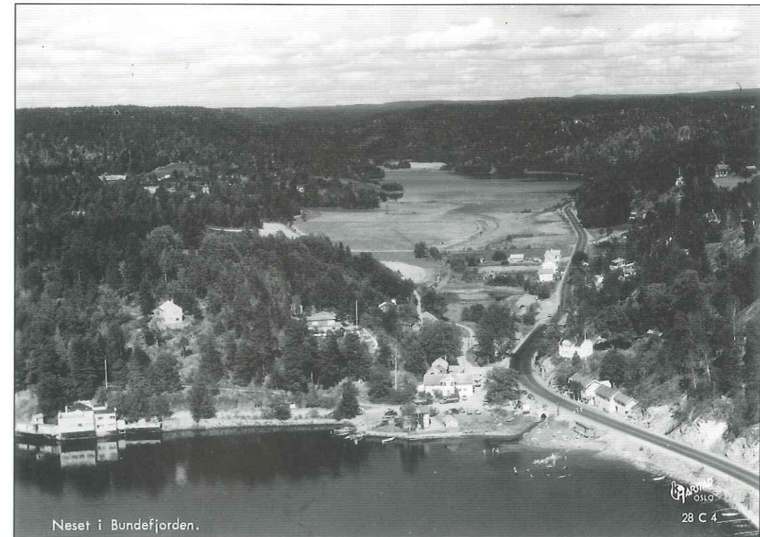
3. Fra Nesset ved Bundefjorden etter krigen. Mosseveien forlater Bundefjorden mellom Hvervenbukta og Nesset. Den har i mellomtiden fulgt Gjersjøelva og Gjersjøen før den fra Vinterbro passerer forbi sørsiden av Pollevannet i bakgrunnen. Nordby-tunnelen har overtatt gjennomgangstrafikken nå.
