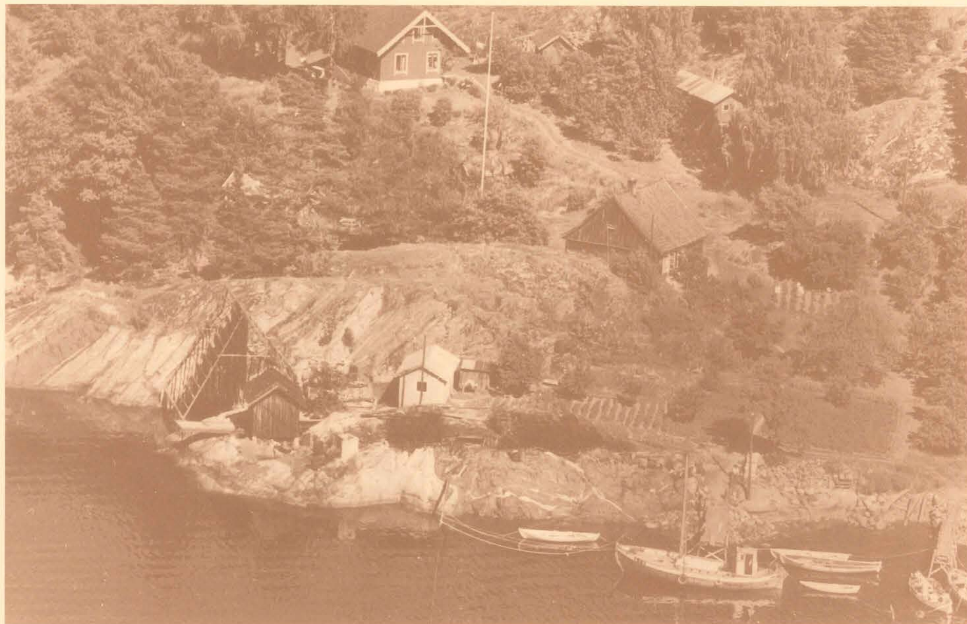
Sjødalsstrand - flyfotografert trolig 1935
