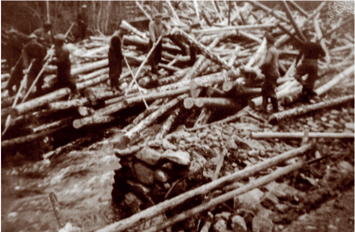
Tømmerfløting i Isielva en gang mellom 1900 og 1930. Elva var smal mange steder, og det ble fort tømmervaser. Særlig i de mest svingete partiene i elva nedenfor Kavlebrua (4) ble det bygget opp steinmur for å geleide tømmeret. Rester av disse er synlige i dag. Var det for ille, sprengte de vasene med dynamitt. Foto Bærum bibliotek, Bærumssamlingen
