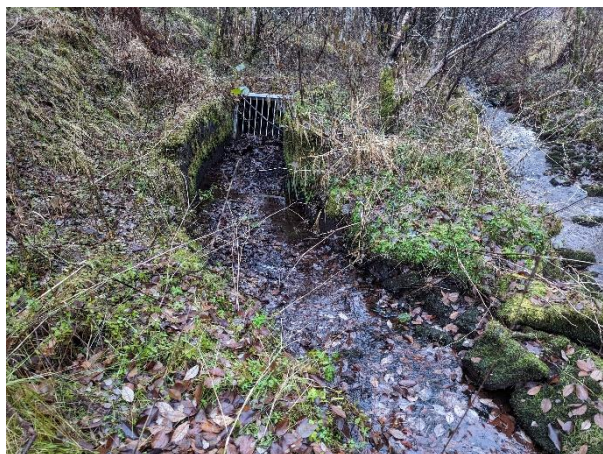
Figur 85. Vannuttak i Ådlandsbekken ca. 100 meter oppstrøms utløpet til sjø.
