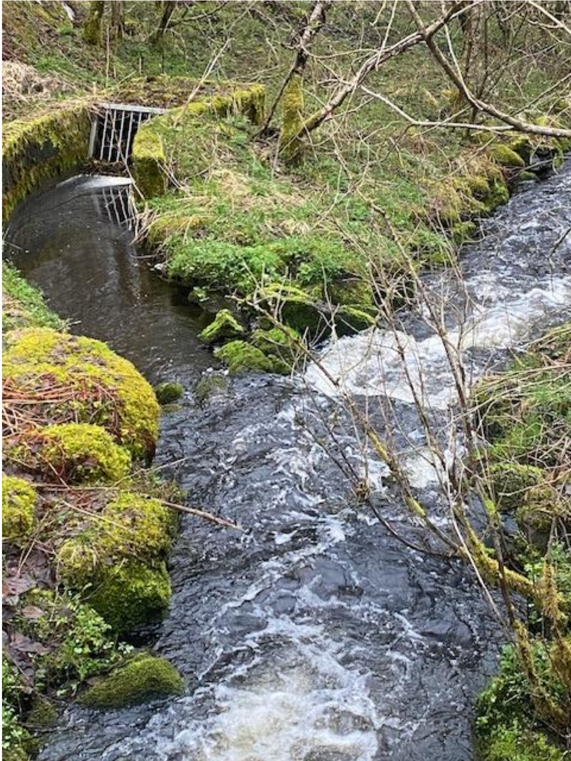
Parti i elven mellom gamlevegen og sjø, overløpstunnel utført av V/A-etaten
