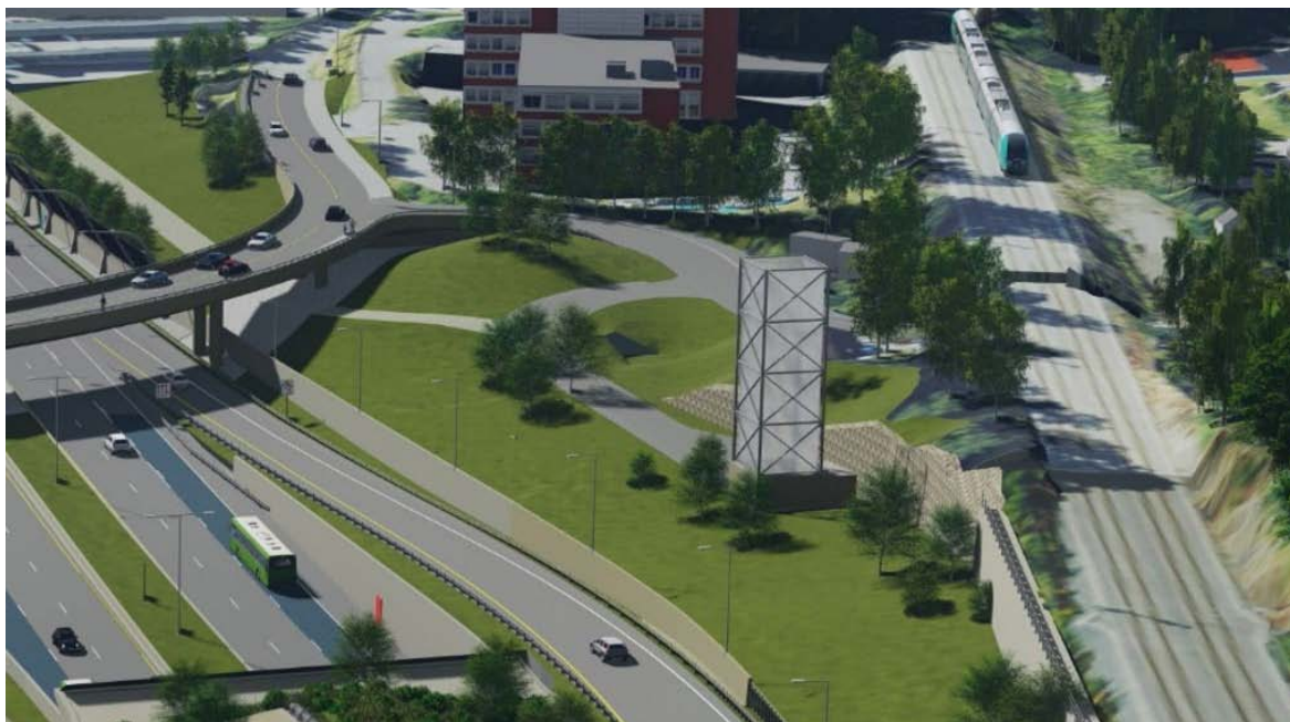
Nytt ventilasjonstårn knyttet til vestgående løp med sjakt
