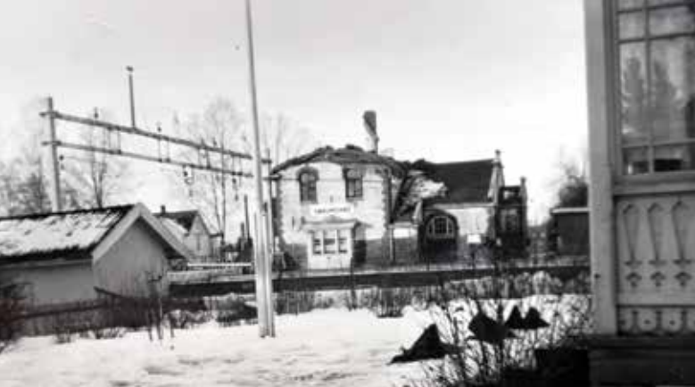
Dette bildet er tatt av Trygve Valstad i 1962. Det viser stasjonsbygningen under oppussing, bl.a. med revet tak.
