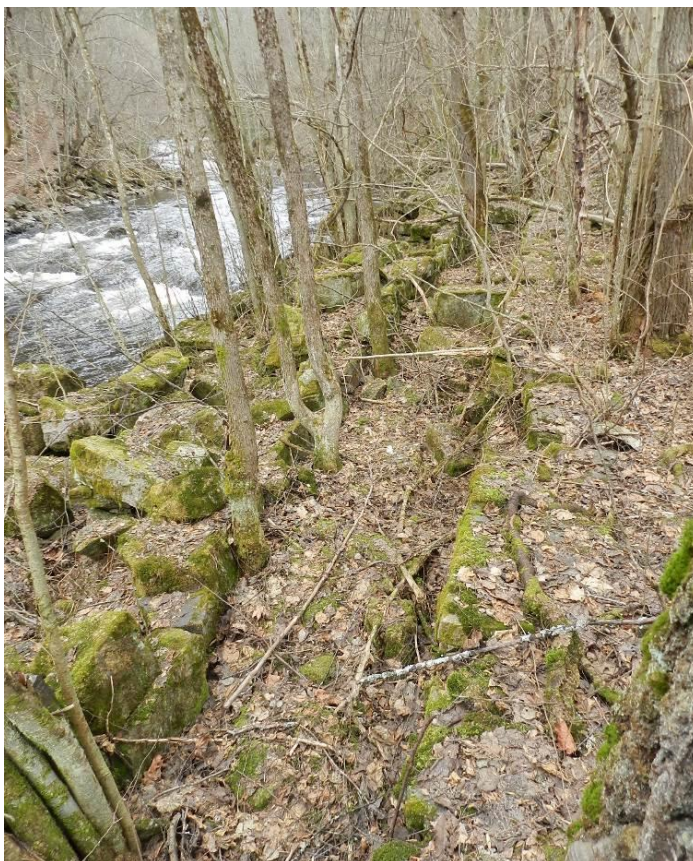
Figur UM1: Avrennet bak mølle. 80 cm bred og 15 m lang. Til venstre flommuren
