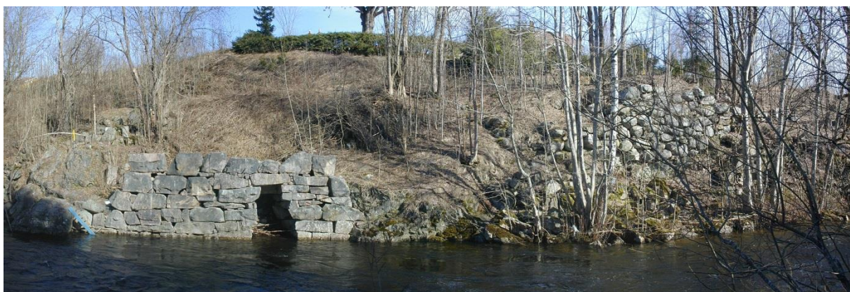
Figur V7: Panoramabilde av restene etter mølleanlegget på Voksen. Fra venstre; Syenettgangen som forankret demningen, fundamentet til møllehuset, elvesiden forsterket med store steiner nedenfor stedet hvor tørkehuset engang sto. Øverst gjennom trær og kratt skimtes Mølleplassen. Helt til venstre går syenitt ringgangen til Bærums kaldera som danner demningsstøtten.
