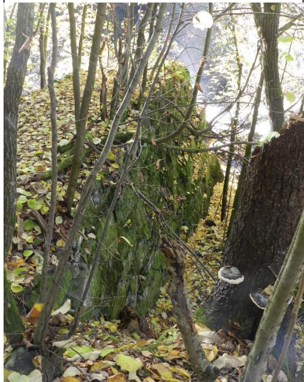
Figur RM16: Oppstrømssiden av damkara (sett fra nordøst). Den er 10 meter lang og 2,6 meter bred på toppen.
