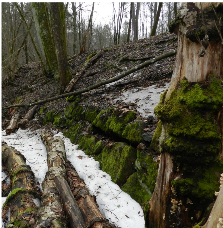
Figur NJ1: På sagtomta på nedre Jar finns denne 25 meter lange støttemur parallelt med elvestrømmen 30 meter nedstrøms demningspunktet.
