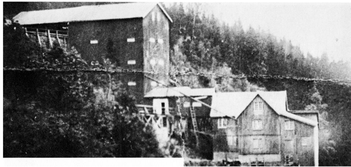
Figur RM8: Fotografi av Røa mølle tatt fra mølledammen. Det viser lagerbygget til venstre og hoved hus på mølla til høyre. I andre versjoner vises demningen nederst og vannrenna som entrer mølla til høyre for den sentrale fløyen i møllas hovedhus. Det bakre bygget med skrånende tak som sees helt til høyre antas å dekke vannhjulet
