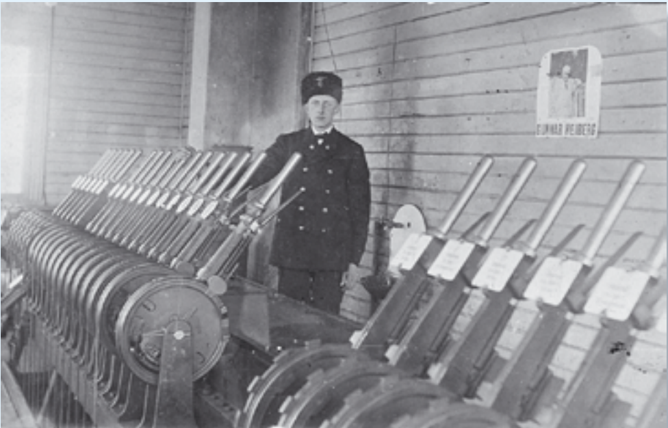
Tysk mekanisk stillverk på Ski stasjon ca 1910. Bildet viser signalstillene, sporvekselstillene og noen mindre stillerhåndtak. Etter hvert som trafikken økte og togene gikk raskere, ble det nødvendig å øke sikkerheten mot ulykker. Stillverk var signalanlegg som delvis sikret togveiene. En delvis sikring medførte at stillverksoperatøren måtte kontrollere at togveien var ledig. Denne typen sikringsanlegg ble erstattet av komplette sikringsanlegg fra 1922. Med disse hadde man kontroll på at det ikke stod materiell i sporene som toget skulle kjøre på. (Langård/Ruud 2002:88-89) Foto: Ski Lokalhistoriske Arkiv
