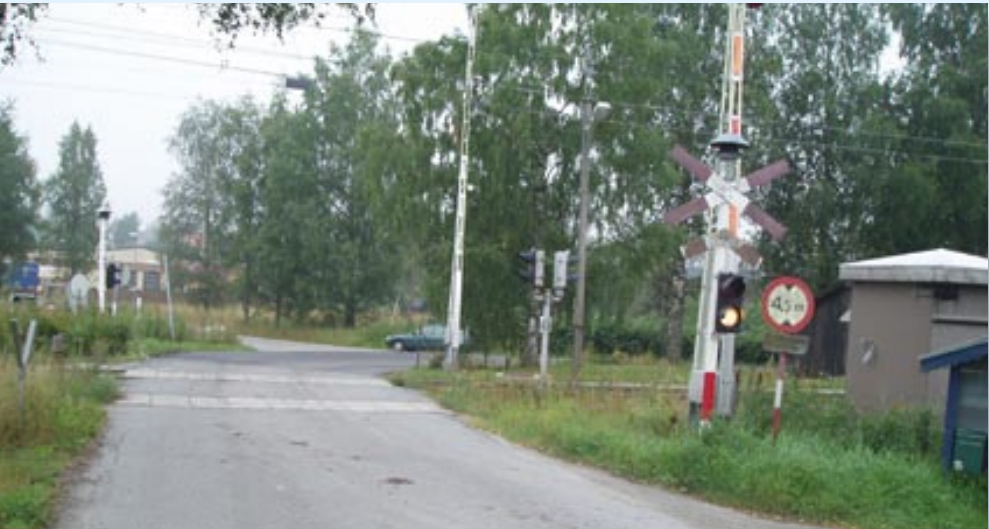
Planovergang ved Kråkstad stasjon 2006. (Foto: Kulturavdelingen)
