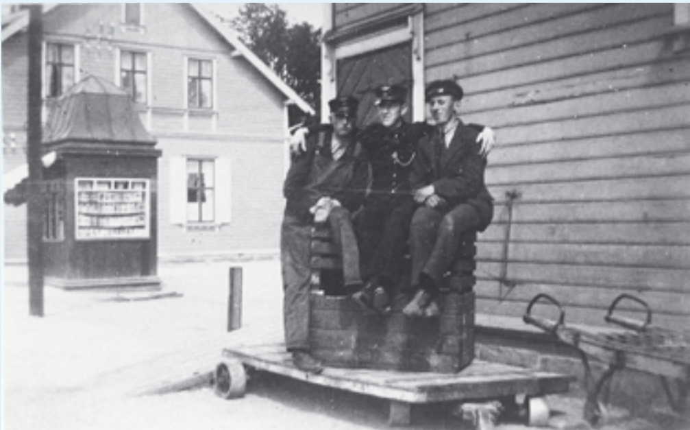
På bildet ser man jernbanekiosken og pakkhuset ved Ski stasjon. Navnene på arbeidsskarene ved pakkhuset er ikke kjent. Foto: Ski Lokalhistoriske Arkiv
