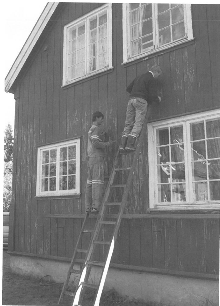
Forberedende malerarbeider – skraping av gammel - løs maling. I stigen: Ove Carstensen og Kjell Johansen.
