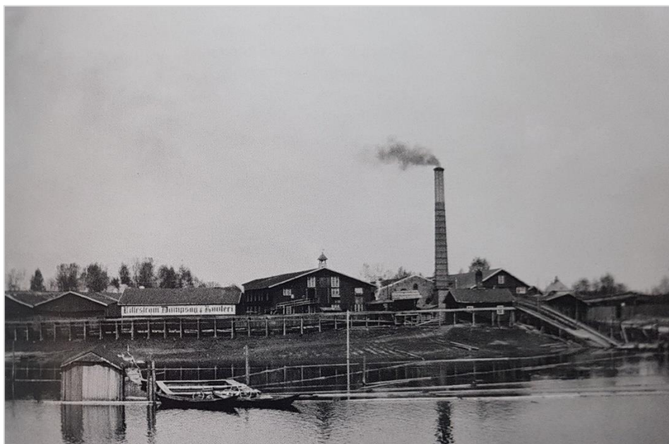
Lillestrøm Dampsgag og Høvleri rundt 1900. Til høyre i bildet kjerraten, som ble brukt til å trekke stokker opp av elva. Foto fra Akershusbasen.
