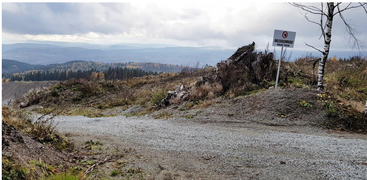
Figur 5 Masseuttaket er ikke sikret med inngjerding
