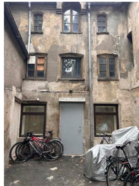
4 - mot tomt bygg (10D)
