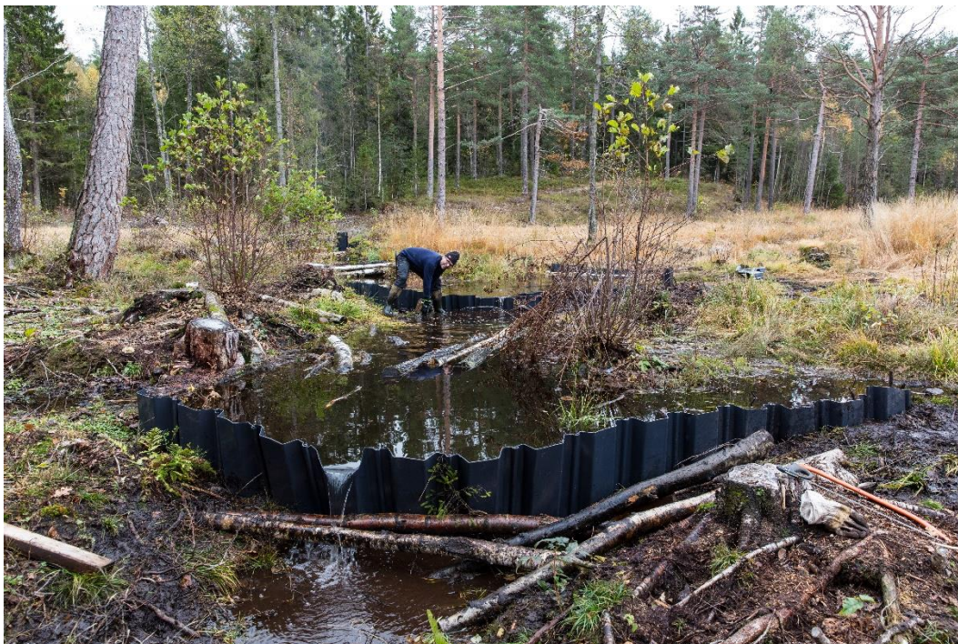
Figur 14: Eksempel på bruk av plastspiler fra Oppsjømyrene naturreservat (Abbotjernmyra) i Asker kommune for å tette grøfter. Foto: Kim Abel.
