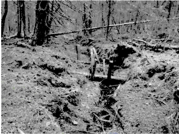
Figur 13. Terskler bygd på 1990-tallet. Vannet har fortsatt å grave, og grøfteskråningene har glidd ut. Foto: Rune Nordeide
