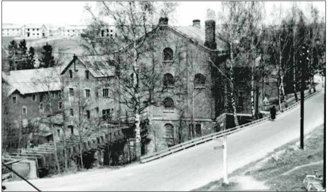
GISLEDAL MØLLE var den største av møllene ved Sagelva. Den var en staselig teglbygning. Medregnet turbinrommet og loftsetasjen var den på hele fem etasjer. Vannet ble tatt inn fra Øvre Møllendam og sluppet ut igjen i Nedre Møllendam, der Strømmensaga henter vann fra i dag. På dette bildet ser vi dessuten Nedre mølle og Spinneriet fra 1888. Foto Conrad Korsmo 1954.
