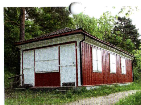
Den nedlagde bygningen til kafé Utsikten i 2015 Foto: Aina Moberg
