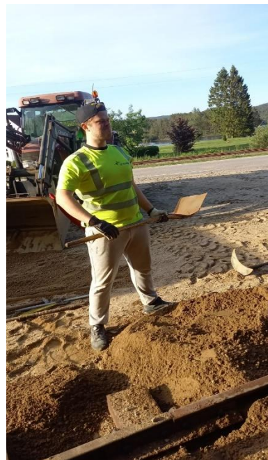
Erlend E Knutsen i gang med å pakke spor 4 på Røyknes Foto: Jarle Larsen
