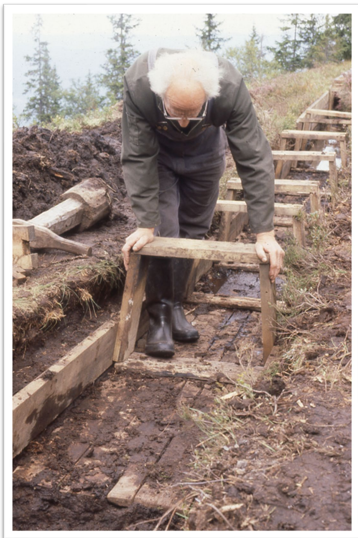
Klemmerenne. Bunn er lagt. Klemmene settes opp som støtte for sidene. Foto: PHS
