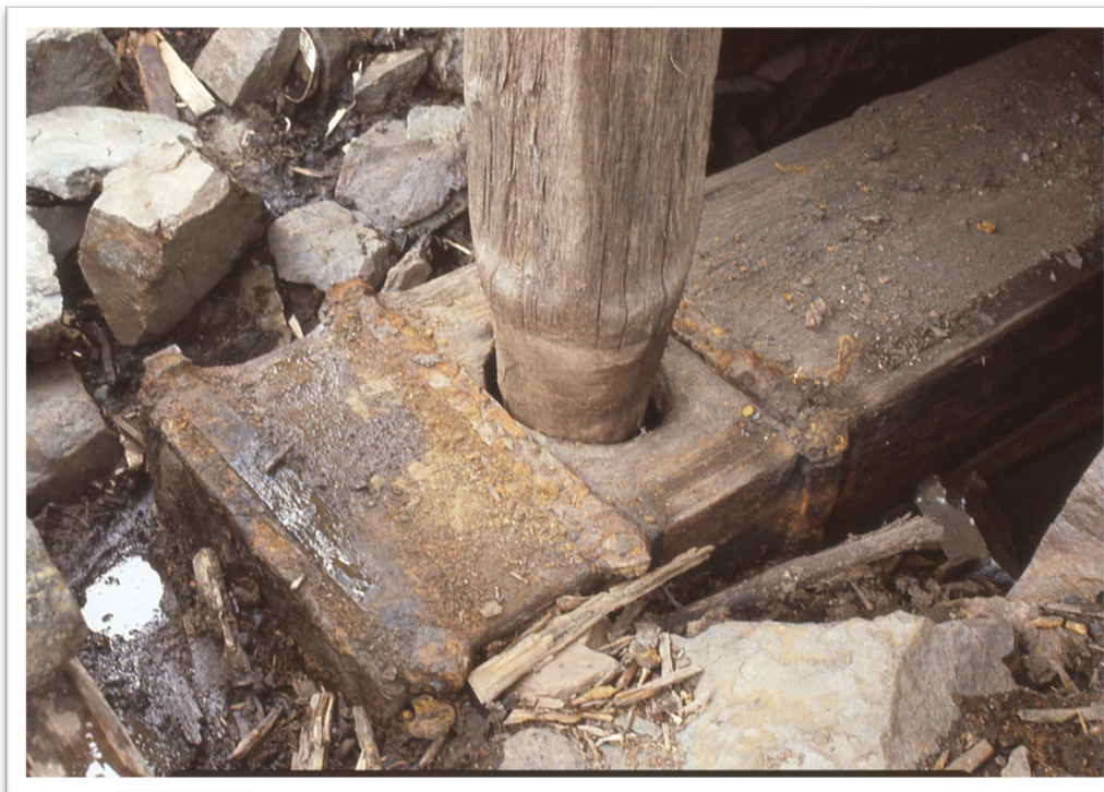
Tappen. Til alle tider reguleringsmekanismen for dammene Foto: PHS
