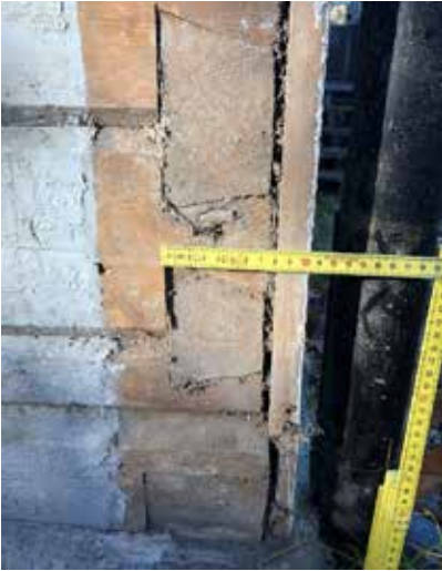
Svalehaleskjøt hjørne maskinlaft.
