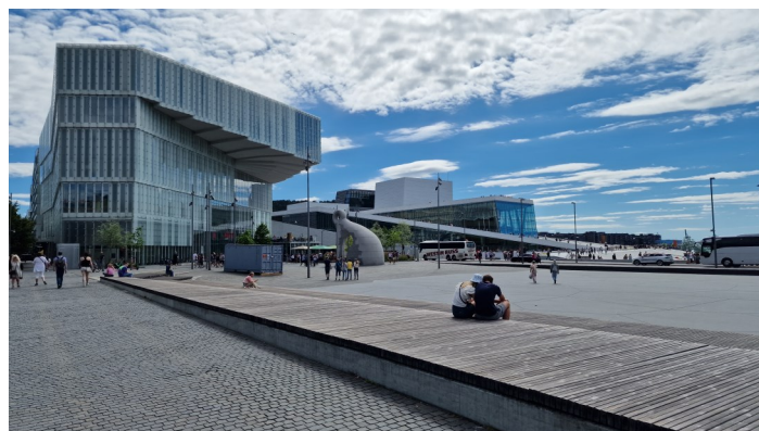
Nye Deichmanske og Operaen på krevende byggegrunn i Bjørvika. Foto: Terje Knudsen.
