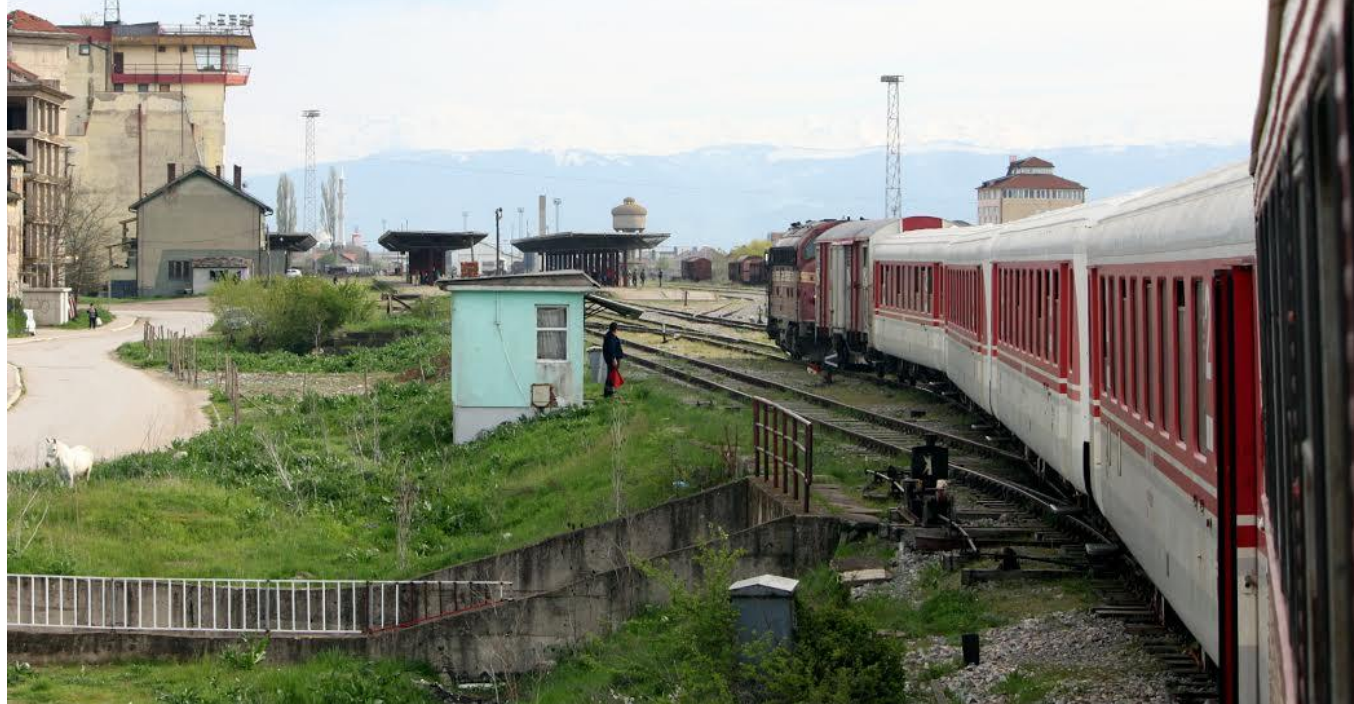
Bilde: Et persontog kjører inn til Fushë Kosovë. I hver ende av stasjonen arbeider en egen mann som legger de håndstilte sporvekslene til riktig togvei. (Personen med det røde flagget midt i bildet) Det imponerende tårnet på stasjonen inneholder et stillverk for sentralstilling av sporvekslene, men dette har aldri blitt tatt i bruk.
