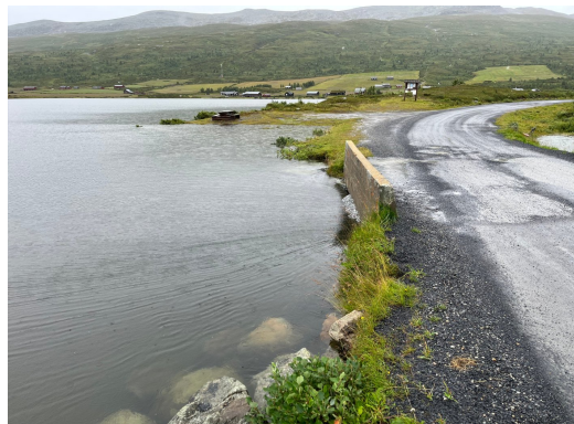
Brua ved Pyttingen 9. august 2023
