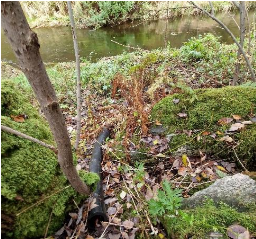
Figur 24 Viser et rør som ikke er ryddet, da det ser ut til å komme ut ifra en steinrøys som er bygget opp ved elvebredden. Ser ut som et privat dreneringsrør e.l.
