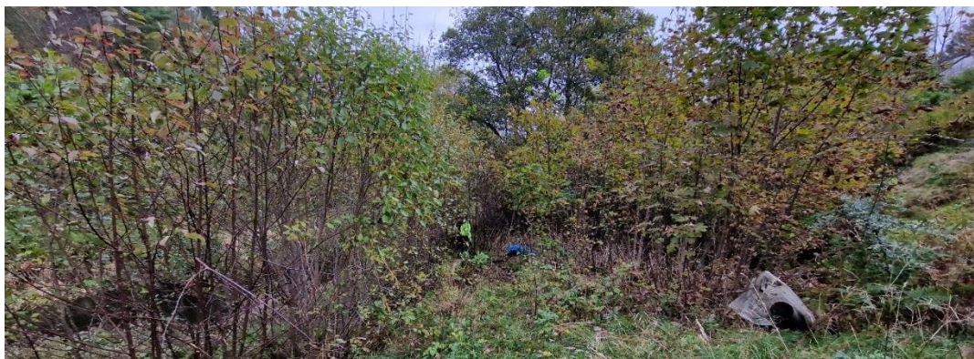
Figur 23 Viser avstanden mellom elvebredden og tilsynelatende noe som er dumpet avfall, ref. figur nedenfor.
