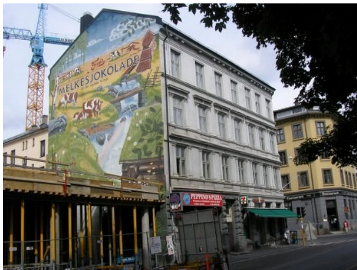
Etter krakket ble mange leiegårder stående med frie endevegger, der det var tenkt tette kvartaler. Denne gården fra 1890-årene i Waldemar Thranes gate ved Alexander Kiellands plass fikk være reklamebærer helt yil 2005. Wikimedia Commons. Foto: Helge Høifødt.
