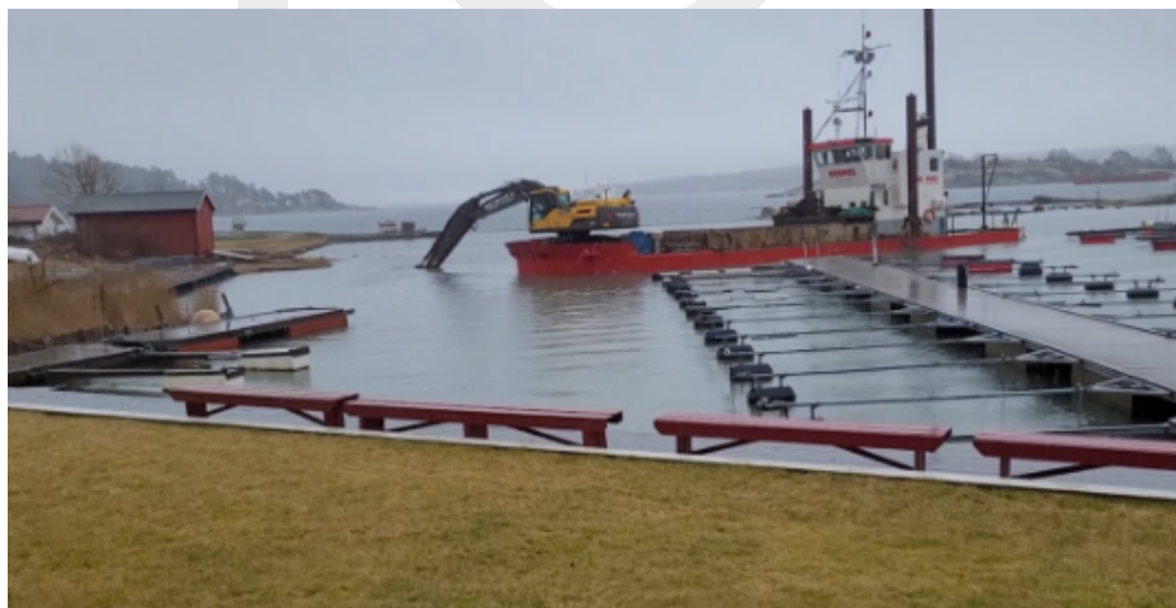
Bilde tatt av kommunen under tilsynet som viser pågående mudring sør for gbnr. 213/21
