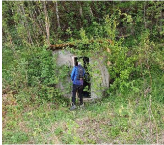
Villy Ruud sjekker dynamitt-lageret ved Tishaugen
