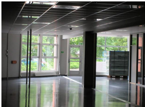
Det begynner å bli ferdig på biblioteket på Rykkinn. Litt forsinkelser i leveransene fører til at åpningstidspunktet ikke er satt. Foto: ES
