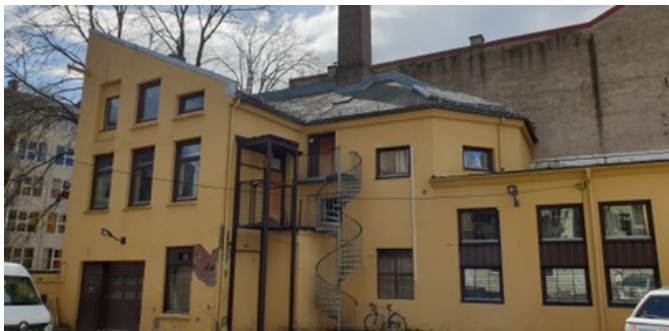
Smedgata 25, verkstedbygning til venstre og bygg mot gaten, april 2020.
