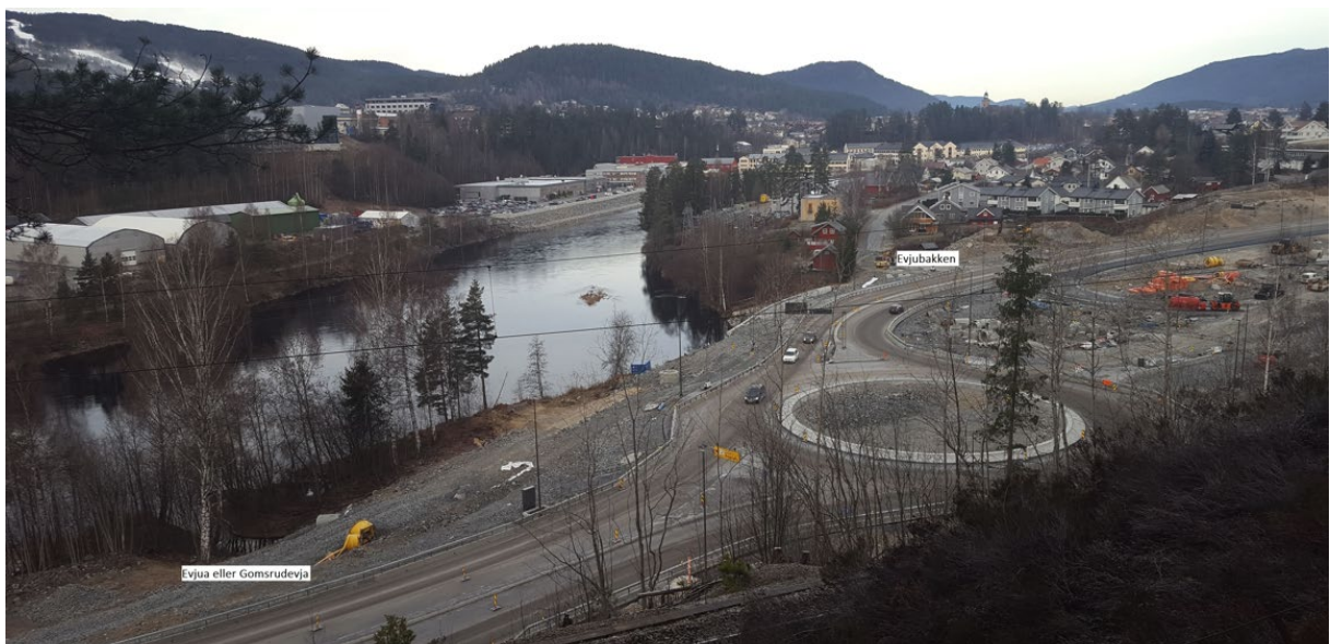
Gomsrudveja og Hallingbakken ( Evjubakken ) under E134 anlegget
