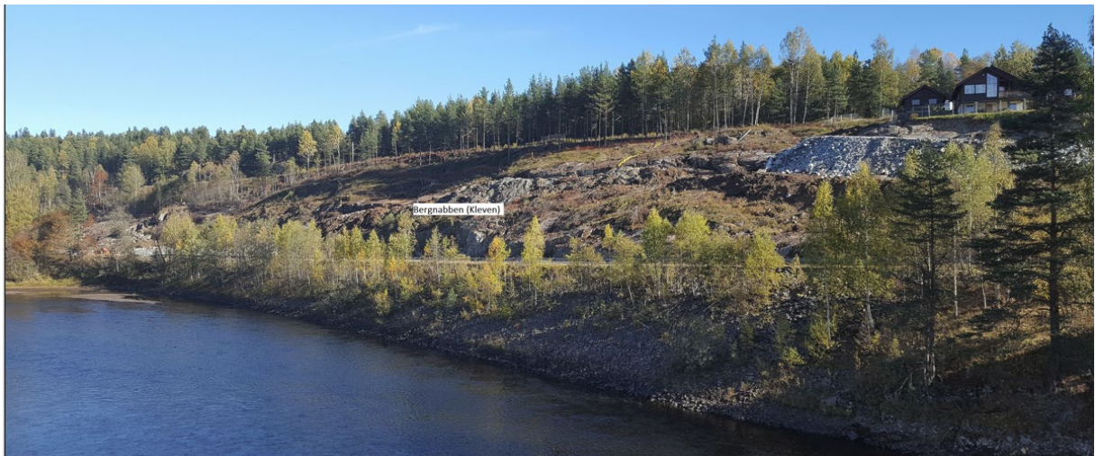
Kleiva (Kleven) før sprengningsarbeidet til ny E134. Gomsrudbrua ligger helt i venstre kant av bildet. (sett fra Bølgen)
