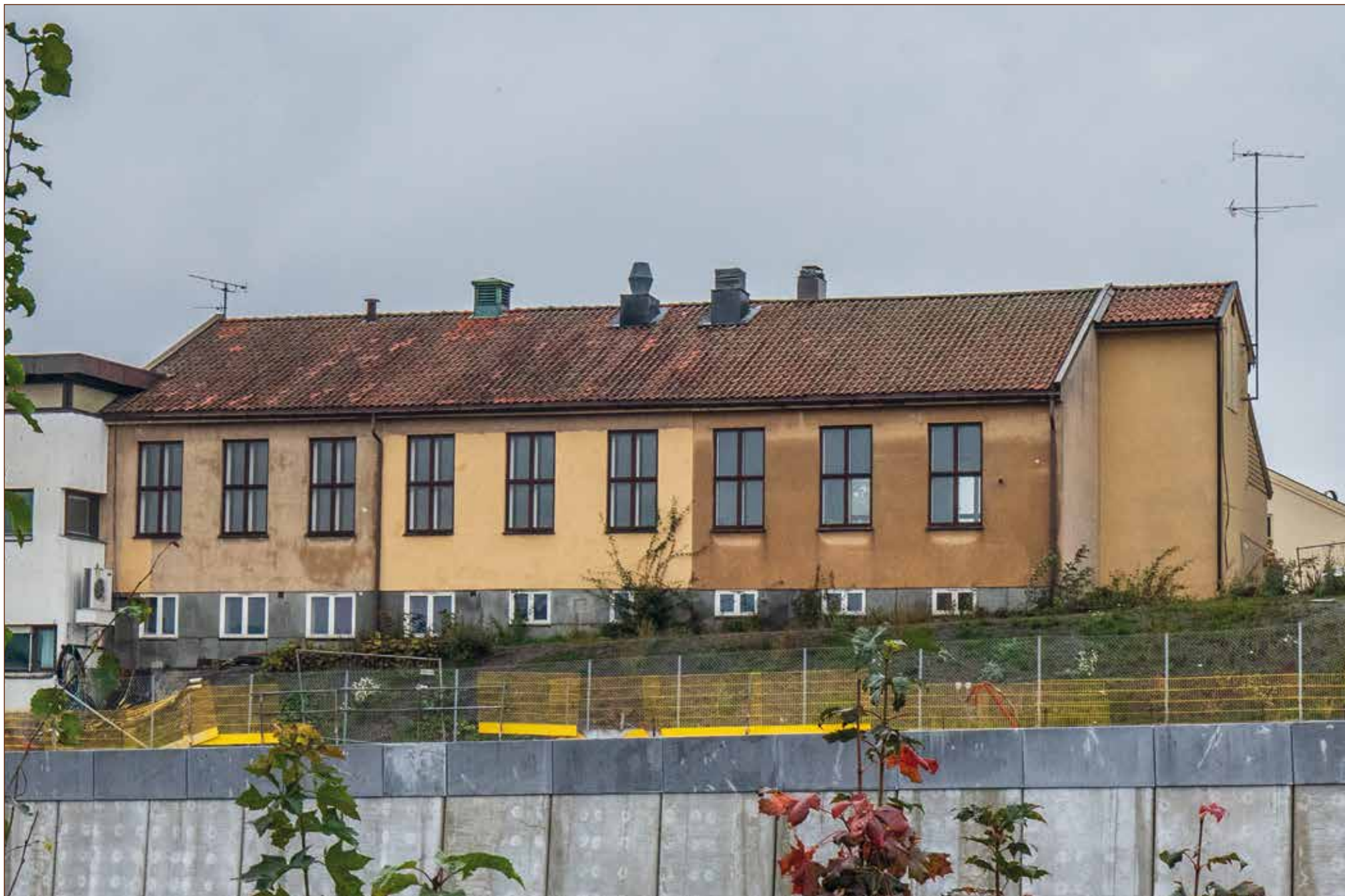
Det eldste bygget i Nordbyveien 1 huset sentralen fra 1954. Foto: Christian Olsen, 2020.
