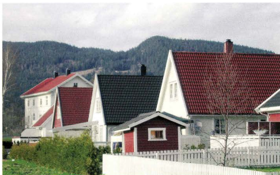
Midtpipehus? Med den eldste skolebygningen fra 1880 i bakgrunnen.
